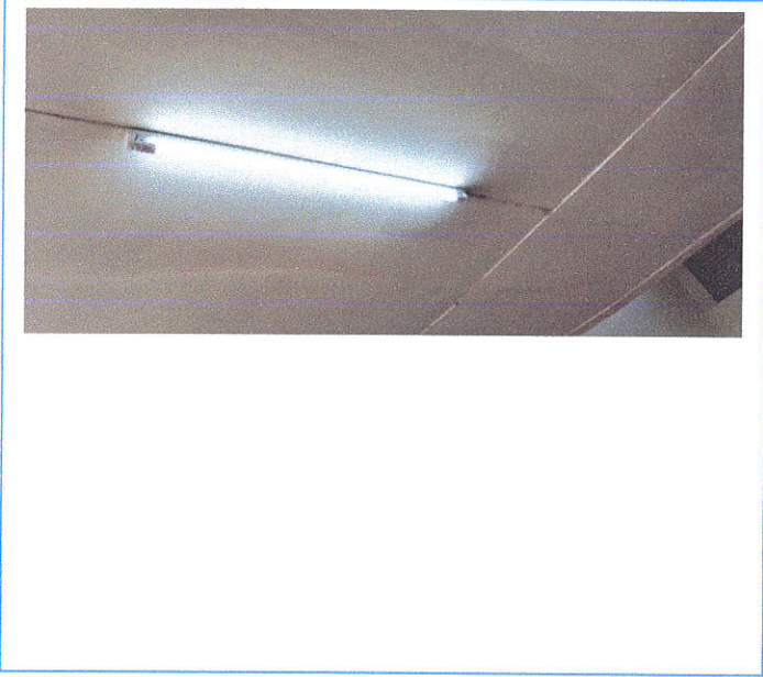
เปลี่ยนหลอดไฟ หลังทำ
